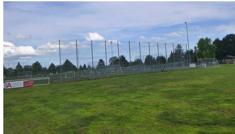
Bild 04: Ballfangzaun auf der Ostseite des Rasenplatzes, Blick nach Südosten
